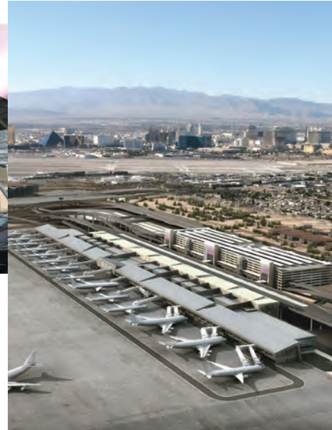
Las Vegas Airport Nevada, USA
